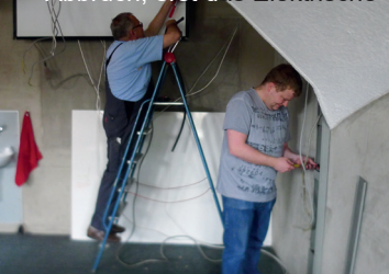
Abbruch, erst das Elektrische
